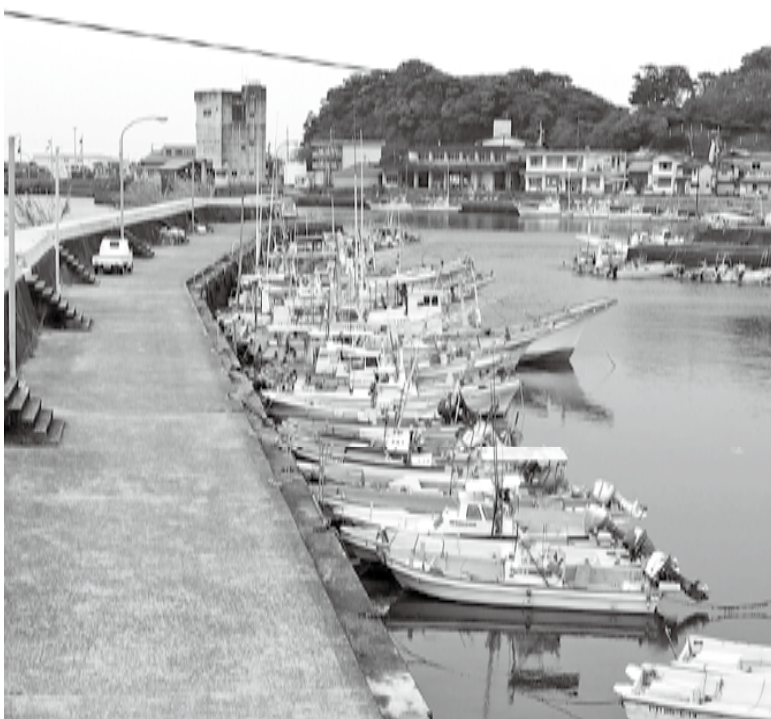
佐賀漁港防波堤かさ上げ工事 (H25年3月末現在)
